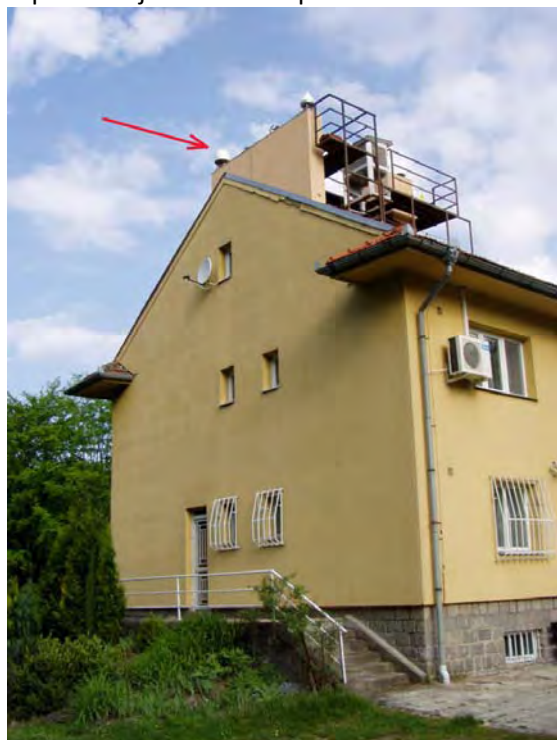
Obr. 11 – Observační pilíř s nucenými centracemi antén technologie GNSS
